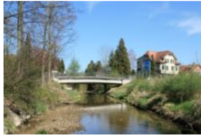
Murgbrücke Kett Sirmach
