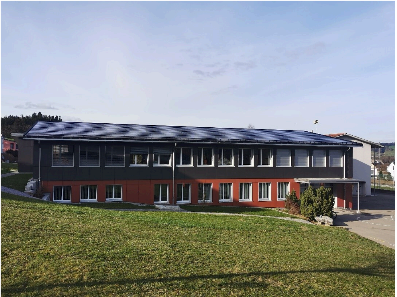
altes Schulhaus Busswil mit Indach-Anlage Baujahr 2022
