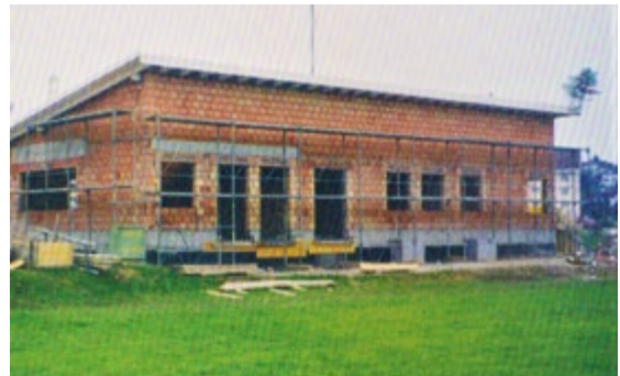
Neues Clubhaus im Bau
