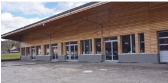
Neubau des Wärmeverbundes und des Handwerkerzentrums 2018
