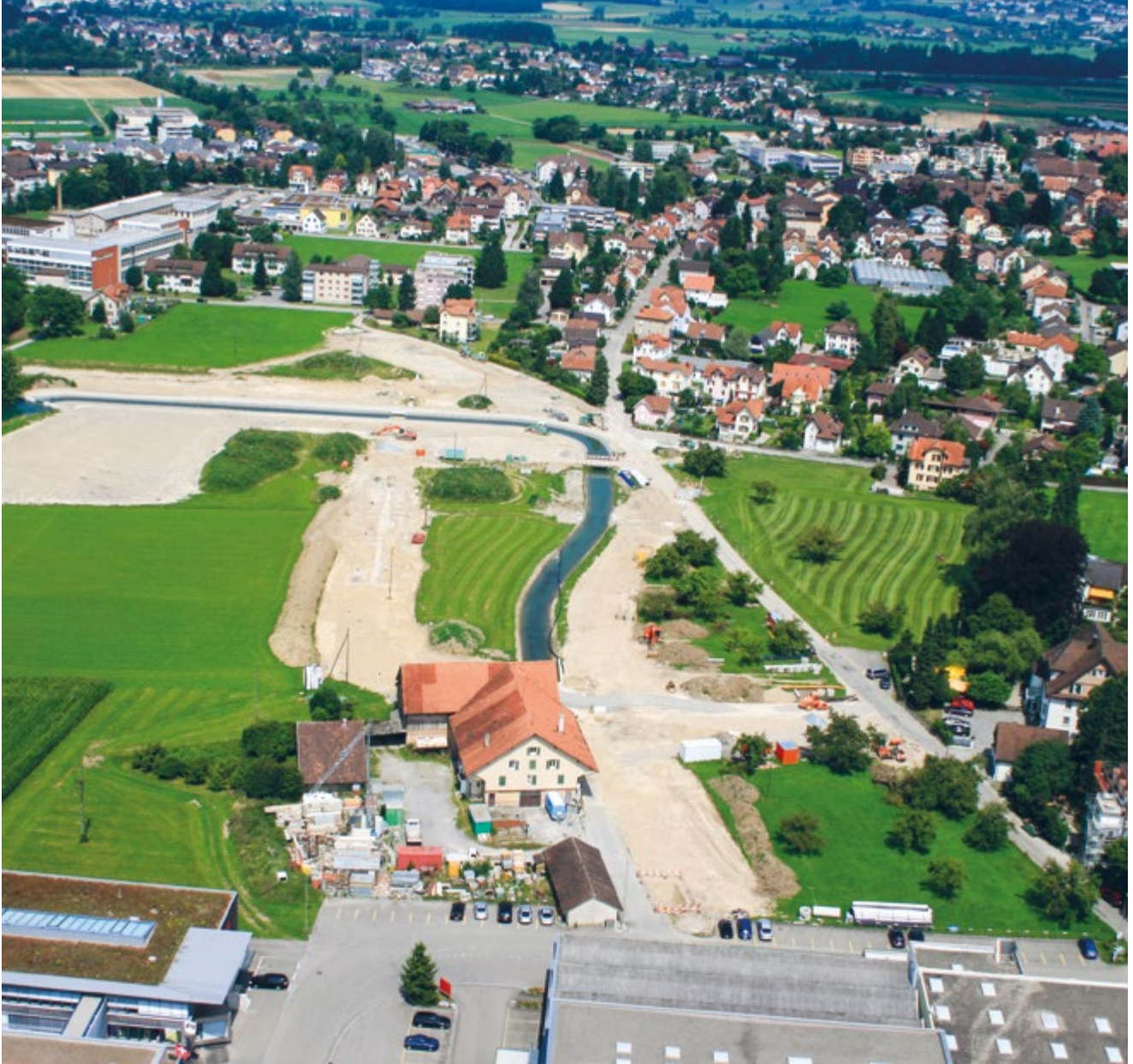
Erschliessungsarbeiten für das Baugebiet Rüti-Murgau im Jahre 2008
