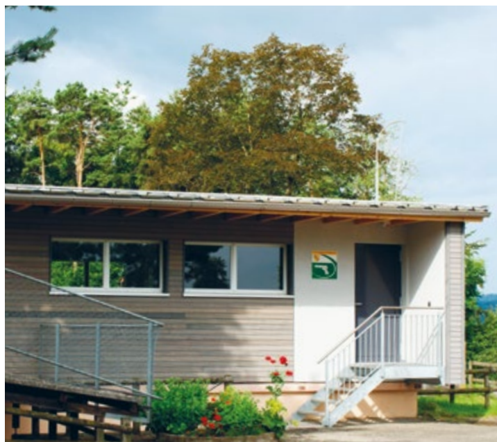
Pistolen-Schiessstand auf der Hochwacht, Sirnach, nach dem Umbau 2014
