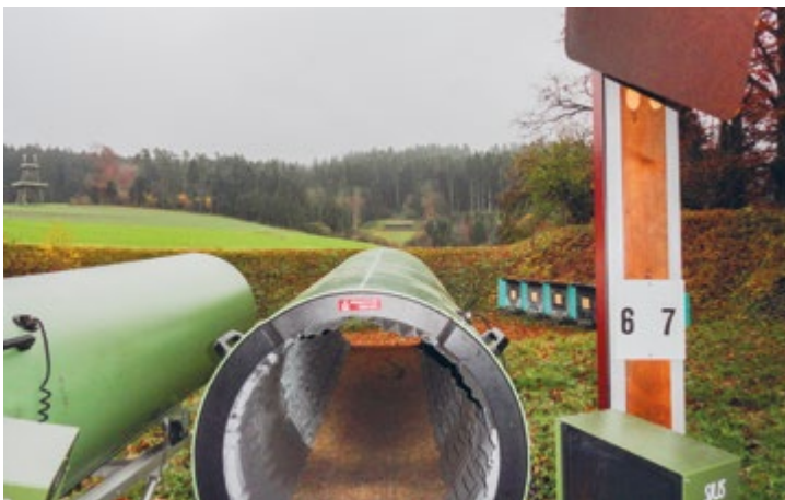
Schiesstunnels im Schützenhaus «Hochwacht» Sirnach
