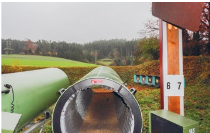
Schiesstunnels im Schützenhaus «Hochwacht» Sirnach
