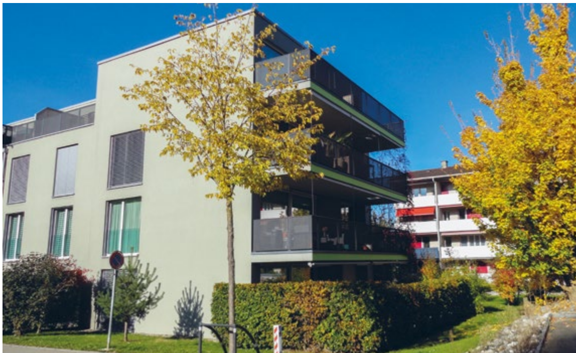
Neubau «Erlenpark» in Kontrast zu den Altbauten
