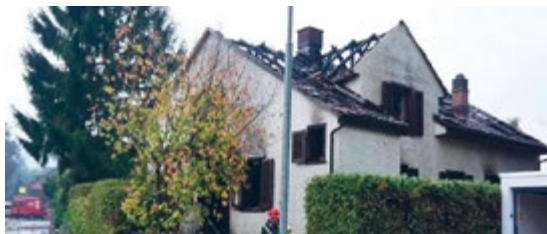
Brand EFH Lindenstrasse Sirnach 2013
