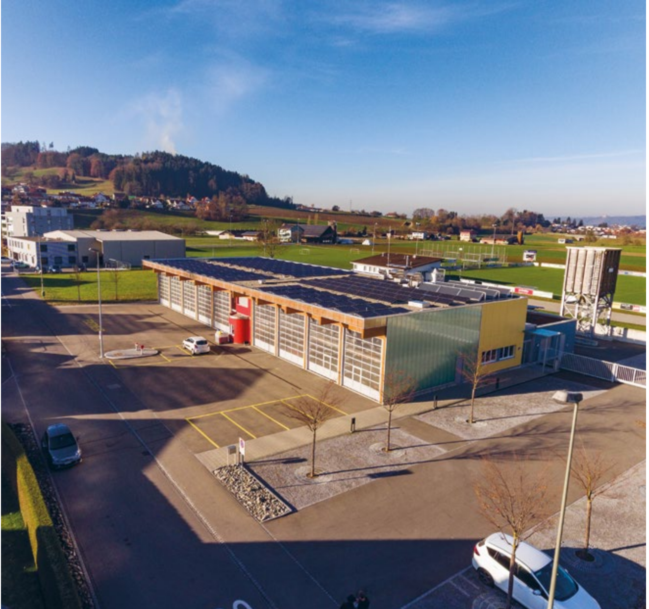
Das neue Depot für Feuerwehr und Werkhof seit 2012
