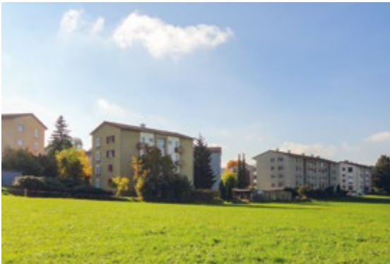
Alte Mehrfamilienhäuser Untermatt aus den 60er Jahren
