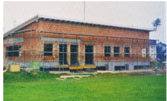
Neues Clubhaus im Bau
