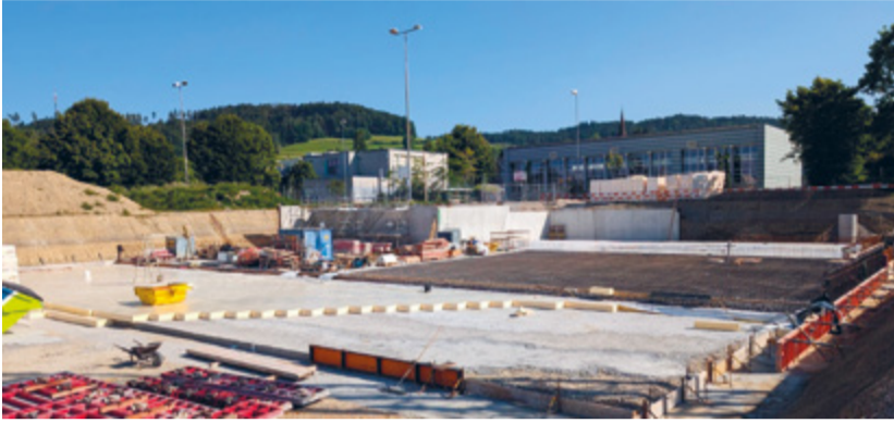
Die Arbeiten auf der gut organisierten Baustelle schreiten voran.
