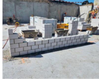
Kalksteinmauer mit sauberer Einteilung und Sichtqualität.
