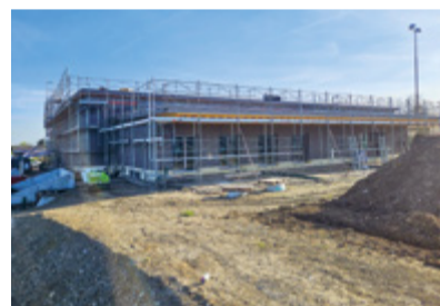
Umgebungsarbeiten in vollem Gange.
