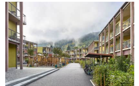
7 Nachbarschaftliche Begegnungszone mit Eingängen und Abstellplätzen Siedlung Oberzelg, Winterthur - Esch Sintzel Architekten
