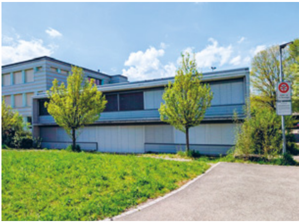
Das Primarschulhaus Grünuu wurde so konzipiert, dass es mit wenig Aufwand aufgestockt werden kann
