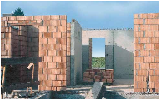
Wohnblock als Mauerwerksbau, ausgesteift mit Stahlbetonwänden [5]
