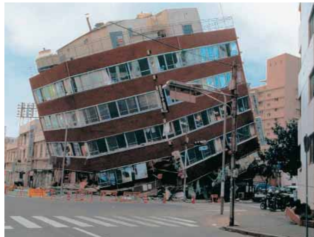
Gebäude mit unsymmetrischer Aussteifung (Kobe Japan 1995) [5]
