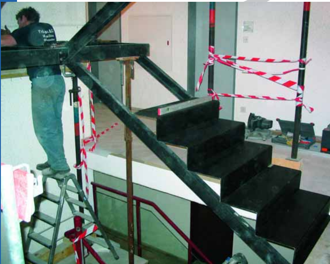
Umbau des Gemeindehauses – 2. Etappe 2005
