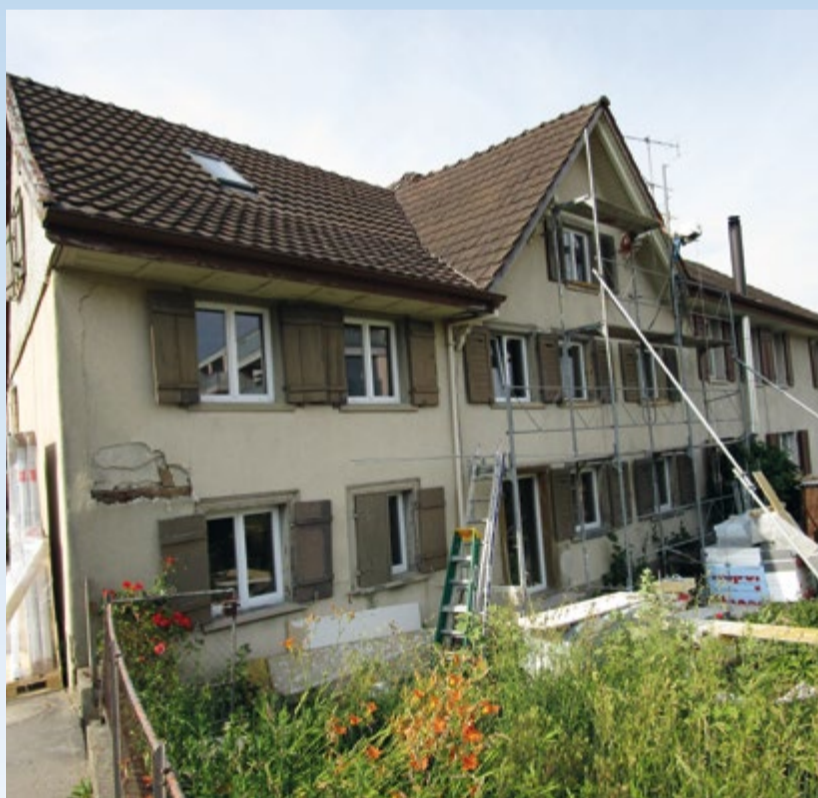
An der Hauptstrasse 15 werden zukünftig asylsuchende Personen eine vorübergehende Unterkunft finden.
